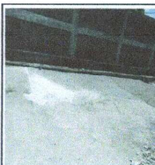
Foto 6: Reparación de pared y puerta
