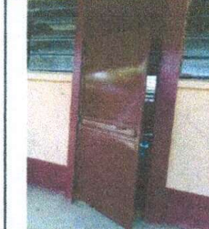
Foto 2: Reparación de puerta y pila
