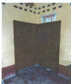
Foto 1: Reparación de Puertas
